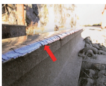
Entre Preglia et Domodossola (km 3.1): un rail avant les travaux. CFF
