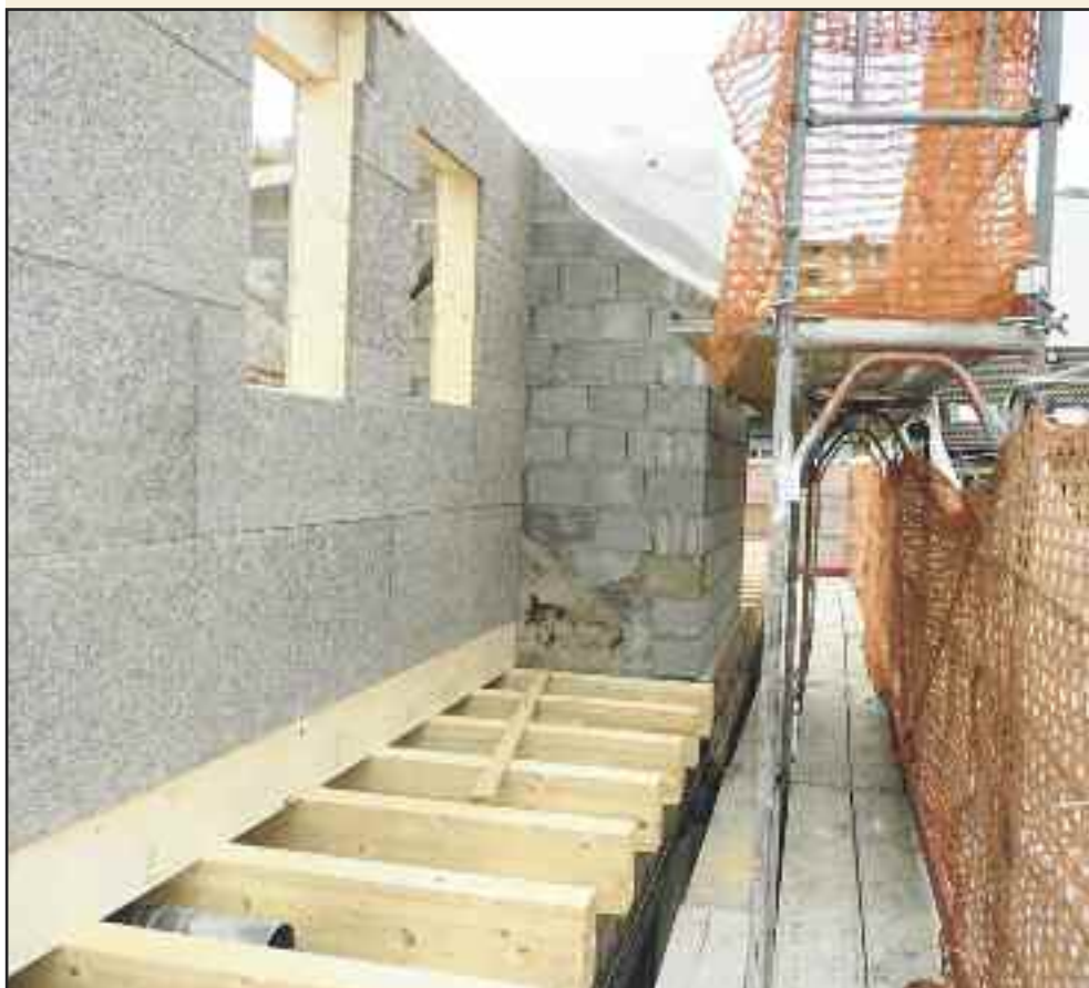
L'attique de la rue de la Borde en chantier. DR
